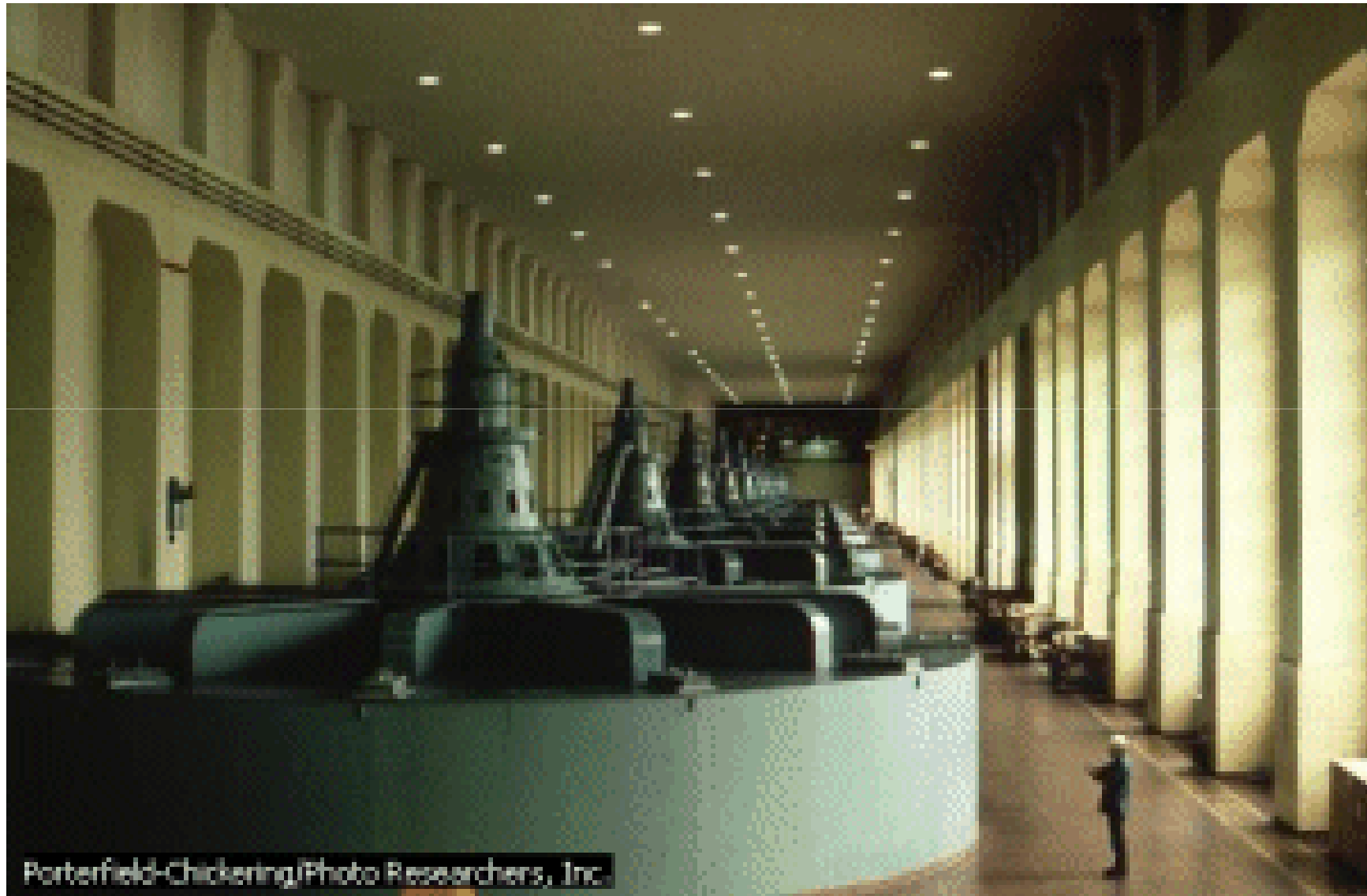
Figura – Gerador de energia em uma hidrelétrica.
