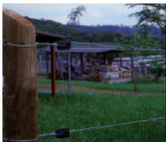
Extremidade de estiramento com detalhe para arremate tipo laçada (superior) e emenda (inferior) usando o sistema Gripple de estiramento
