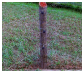
Detalhe de canto ou passagem em ângulo reforçado com traveseiro.
